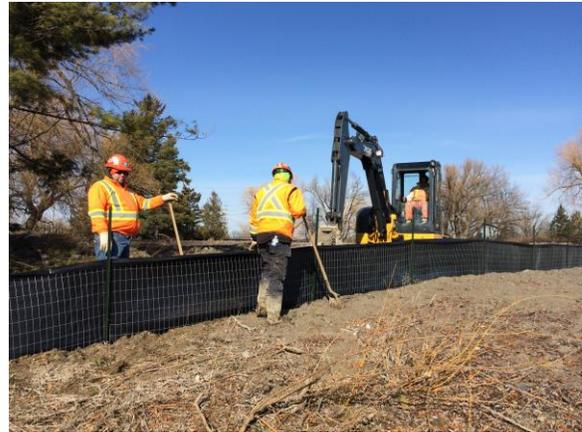
27 février 2018. Installation des contrôles environnementaux, au sud de Rutherford Rd. La clôture en treillis d'acier contrôle l'écoulement des sédiments provenant des sites de préchargement.
