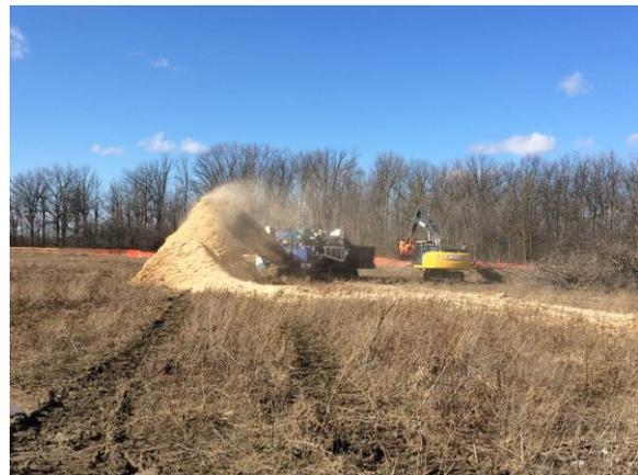
26 février 2018. Opération de nettoyage au nord de Langstaff Rd. Broyage des arbres. Une partie des copeaux de bois sera répandue sur le sol pour réduire l'érosion.
