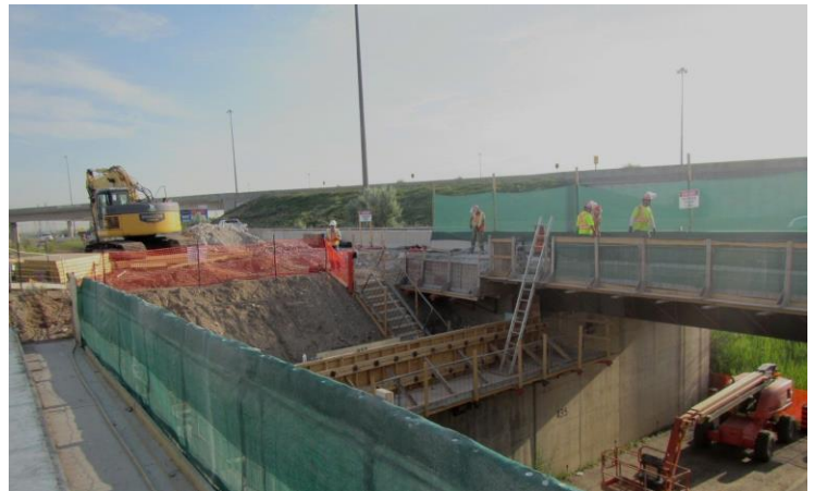
Excavation à la passerelle de l'avenue Steeles pour préparer l'expansion du pont
