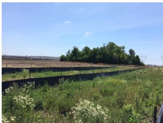
Clôture anti-érosion à câble arrière pour le contrôle des sédiments
