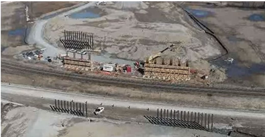
Image de la construction en mars 2019 provenant d'un drone à la voie ferrée CP / chemin McGillivray
