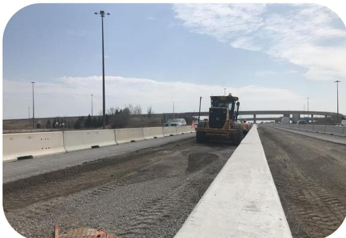
**Niveleuse** : Cette machine aplatit la route avec une longue lame pour créer une surface plane sur laquelle une machine de pavage pose de l'asphalte. Sur la photo à gauche, cette niveleuse prépare la médiane pour le pavage sur l'autoroute 427.
