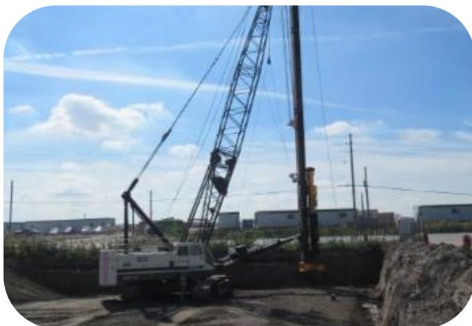
**Sonnettes** : Les pieux sont enfoncés dans le sol pour supporter le poids des structures. Les sonnettes sont des grues qui enfoncent les poteaux dans le sol. Sur la photo à gauche, des pieux sont enfoncés dans le sol à la nouvelle structure de Langstaff Road.
