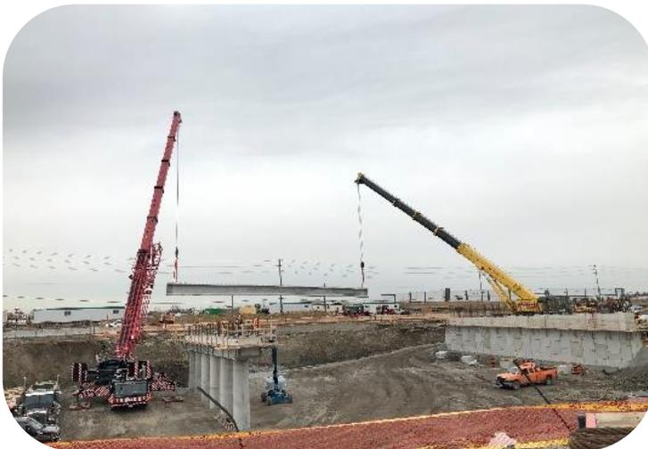
**Grues** : Les grues lèveront des poutres en acier sur les piliers du pont (colonnes). Les poutres soutiendront le tablier du pont, qui est la surface du pont. Sur la photo à gauche, deux grues soulèvent des poutres sur la nouvelle structure de pont à Langstaff Road.
