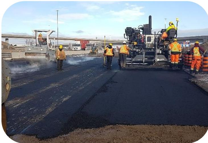
**Asphalteuse** : Une asphalteuse pose de l'asphalte et du béton sur le revêtement de la route. La machine bougera à un rythme constant pour que la surface soit lisse.
