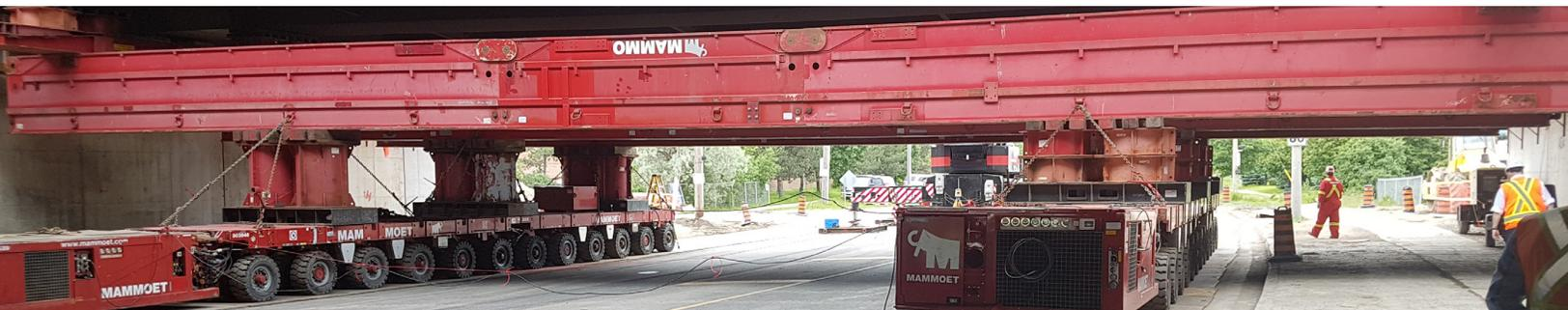
Vue de l'autoroute 427 d'une remorque modulaire autopropulsée installée sous le pont Albion le samedi 16 juin, préparée pour le déplacement du pont
