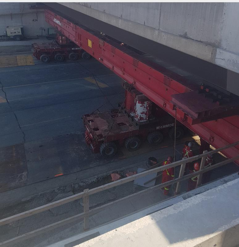
*Vue du chemin Albion de la remorque modulaire autopropulsée installée sous le pont Albion le samedi 16 juin, préparée pour le déplacement du pont.*
