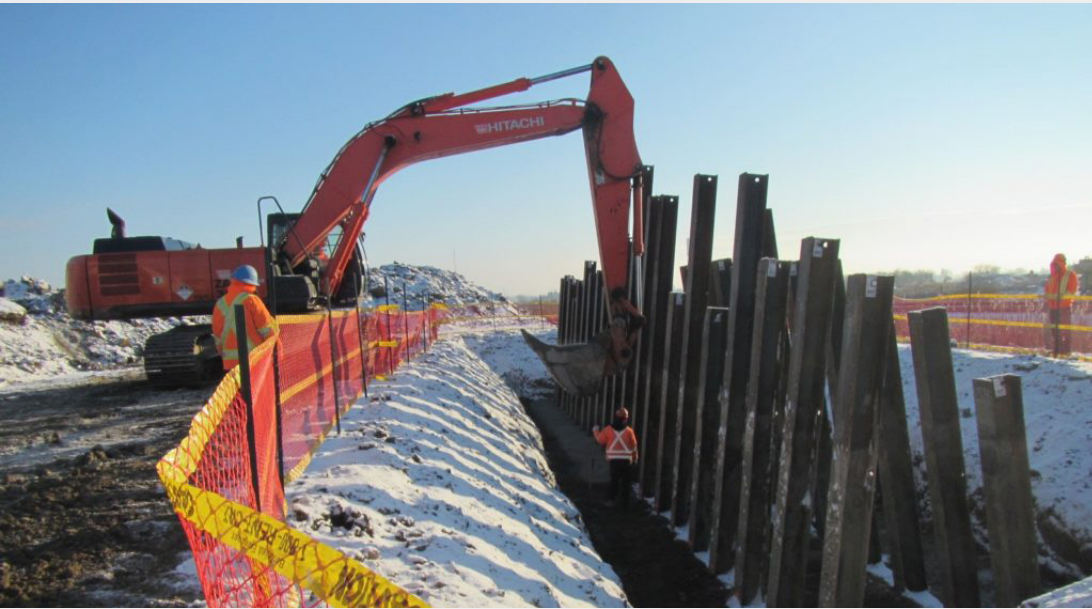
Une photo de pieux pour une fondation profonde de pont qui ont été installés en janvier 2019.
