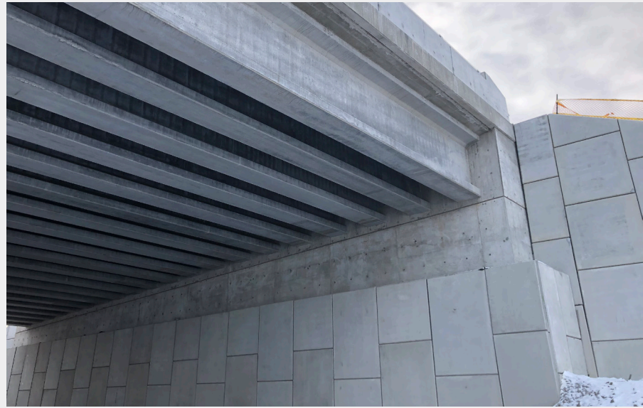
Une culée et des murs RSS au pont du chemin Langstaff sur l'autoroute 427. Les poutres et le tablier du pont (la superstructure) sont installés le long du bord supérieur de la culée.
