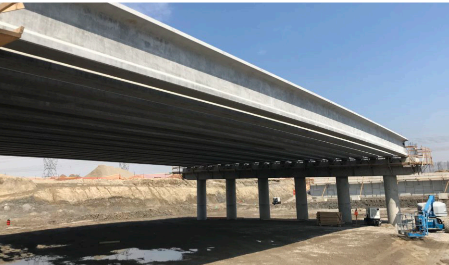
Installation de poutres au chemin Langstaff. La poutre est appelée structure en I parce que la poutre a la forme d'un I.
