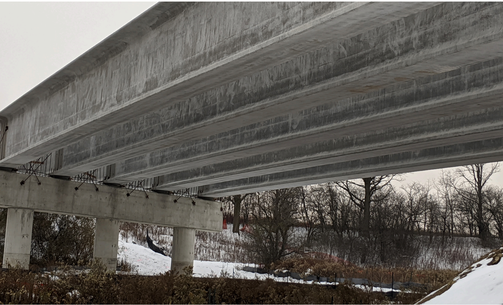
Installation de poutres au-dessus du ruisseau West Robinson.
