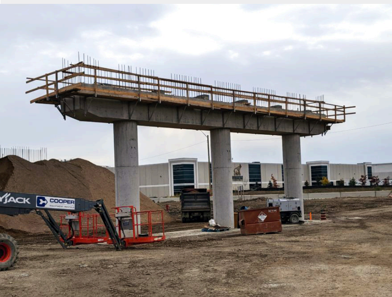
Construction d'un pilier pour le futur tracé du boulevard Zenway.
