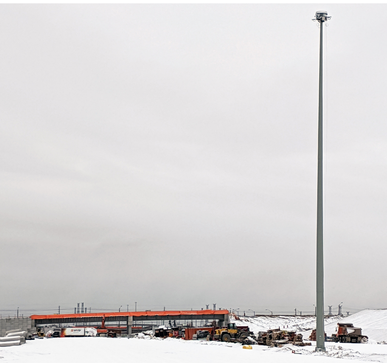
Mât d'éclairage récemment installé près du ruisseau Rainbow.
