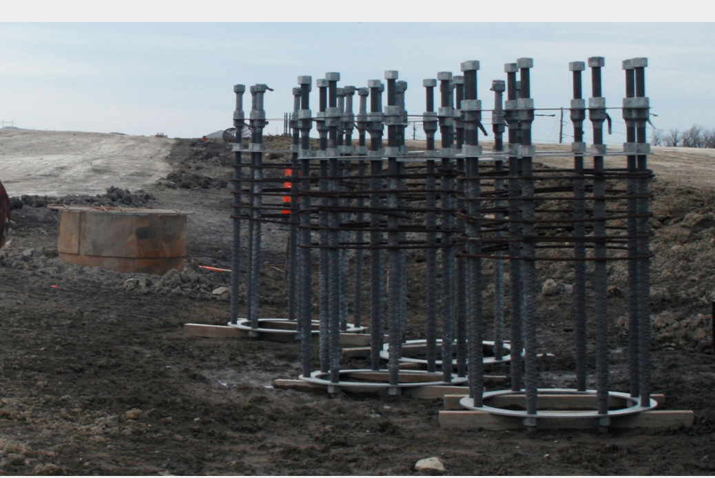
Barre d'armature pour la base du mât d'éclairage.
