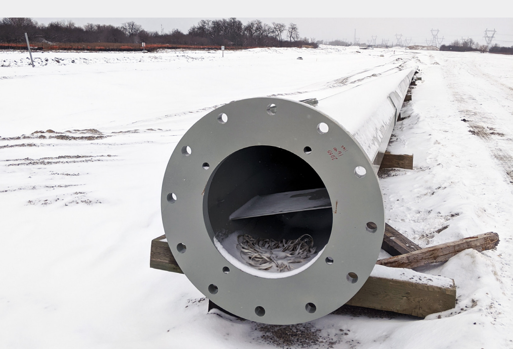
Mât d'éclairage prêt à être installé sur le prolongement de l'autoroute 427 entre les chemins Rutherford et McGillivray.
