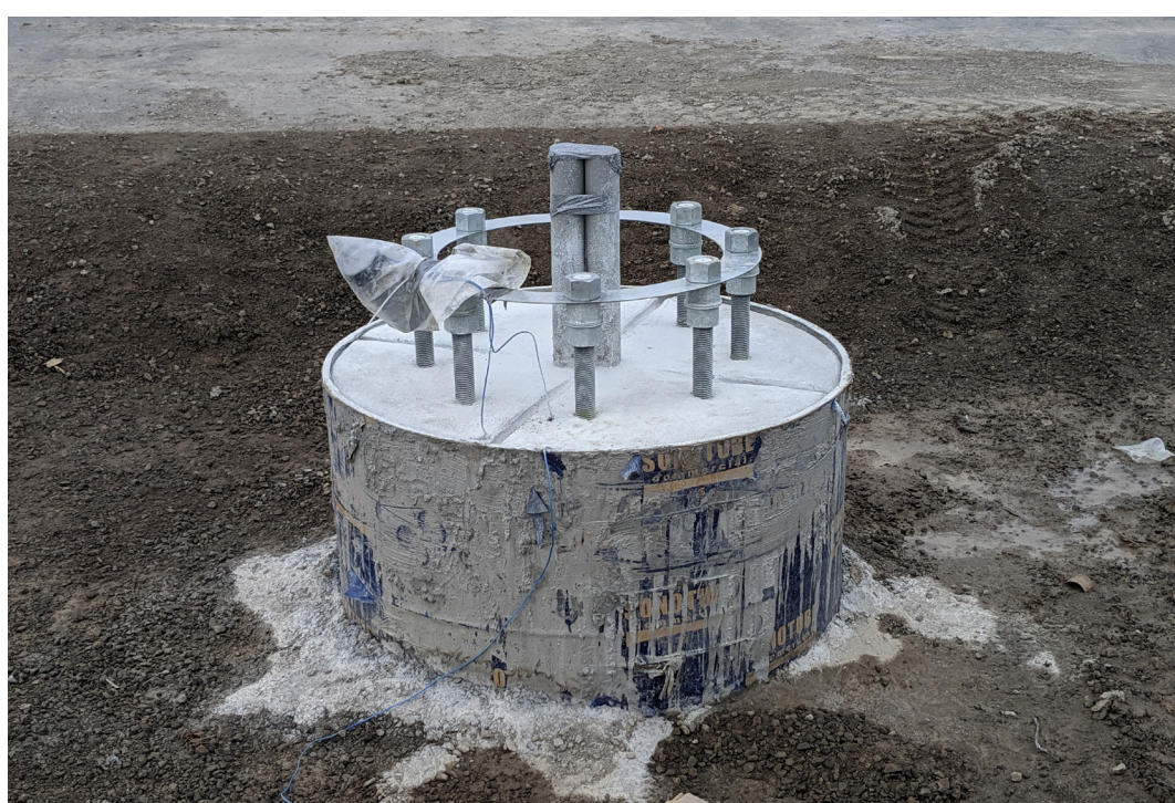
Assemblage de boulons d'ancrage pour un mât d'éclairage de type haut mât.
