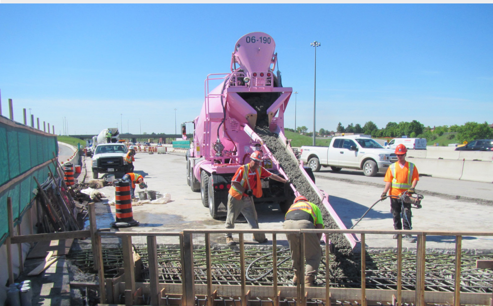
Des ouvriers coulant du béton dans les voies en direction du nord de l'autoroute 427.
