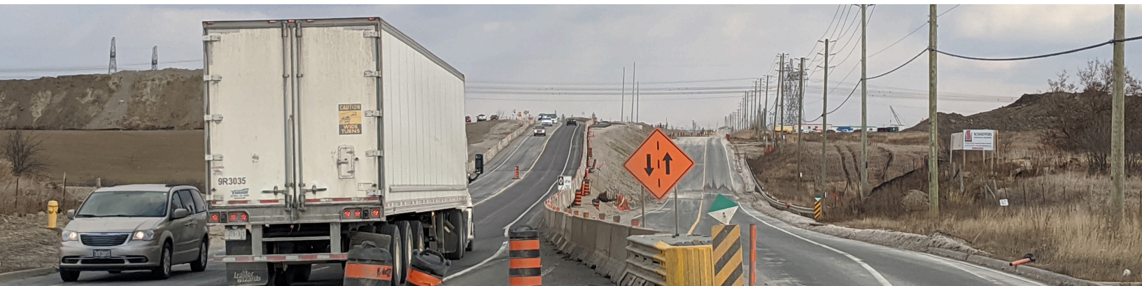
Véhicules circulant sur le nouveau tracé du chemin Langstaff. L'ancien tracé de la route est visible dans la moitié droite de la photo. Le chemin Langstaff a été déplacé le 29 novembre 2019.
