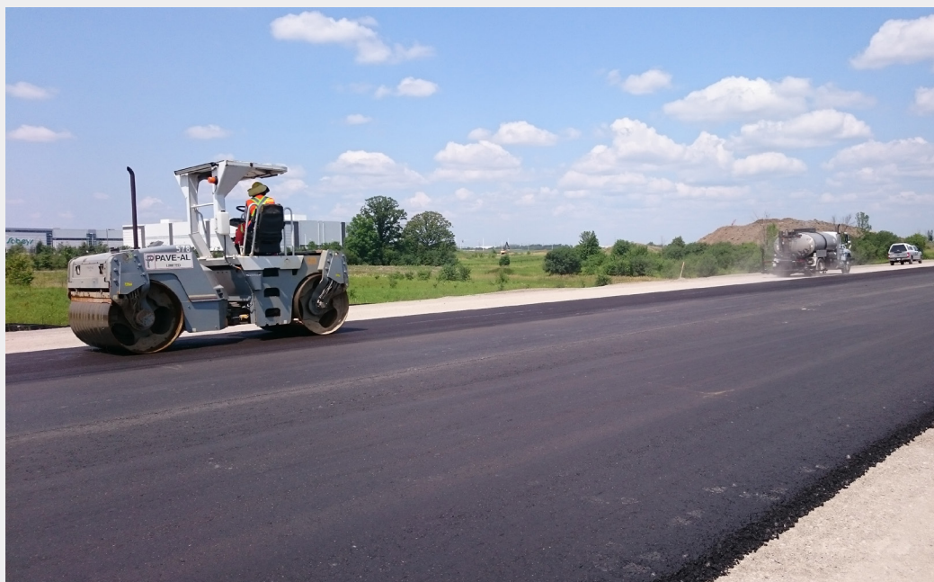
Travaux de pavage au nord du boulevard Zenway.
