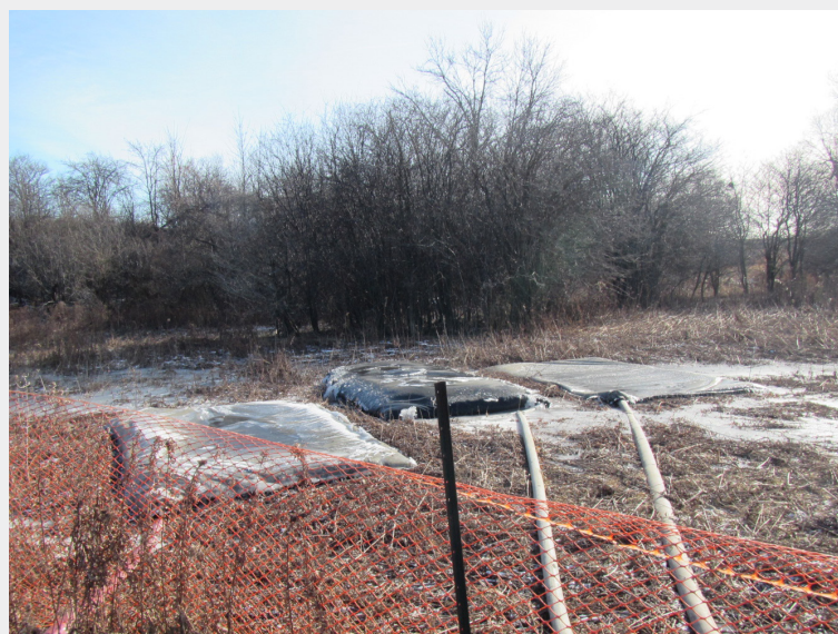
Station d'assèchement avec des sacs de sédiments près de Rainbow Creek.
