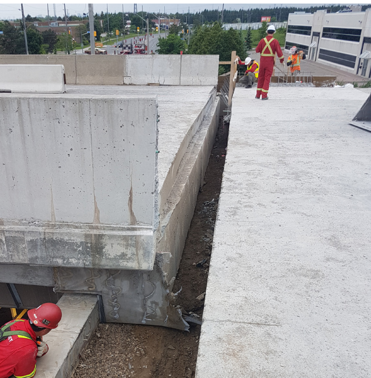
Pont Albion vers la fin du processus de relocalisation.
