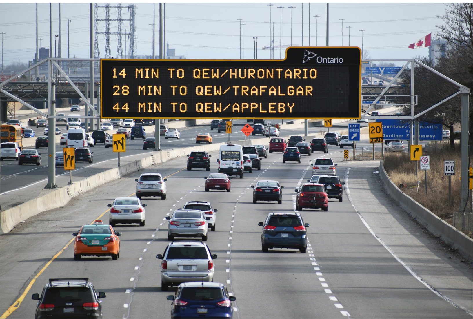
Un panneau à message variable au-dessus des voies collectrices de l'autoroute 427 en direction du sud, près du chemin Burnhamthorpe à Toronto, indiquant les temps de parcours.
