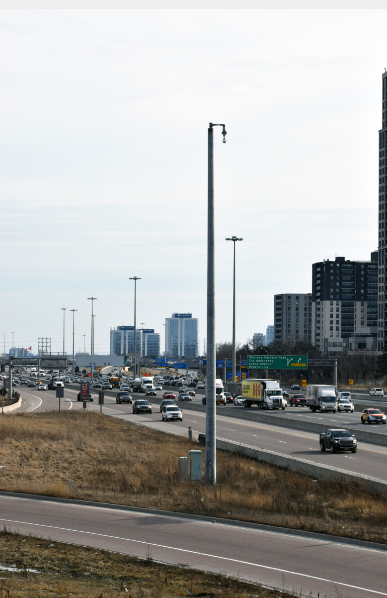
Une caméra CCTV montée sur un poteau à l'échangeur de l'autoroute 427 et le chemin Burnhamthorpe à Toronto.
