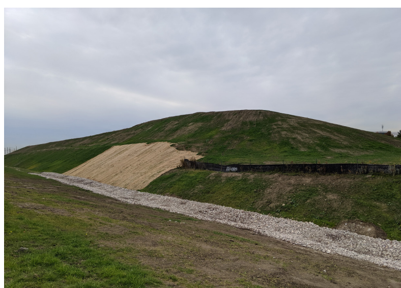
Remblai et fossé végétalisés en cours de finalisation entre le boulevard Zenway et le chemin Langstaff.
